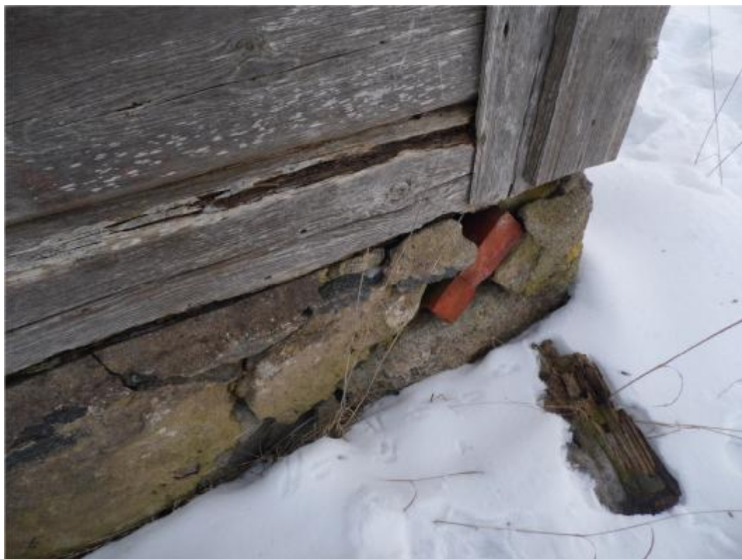
Фото №11. Участки выпадения камней из «тела» бутовой кладки цоколя и фундамента.
